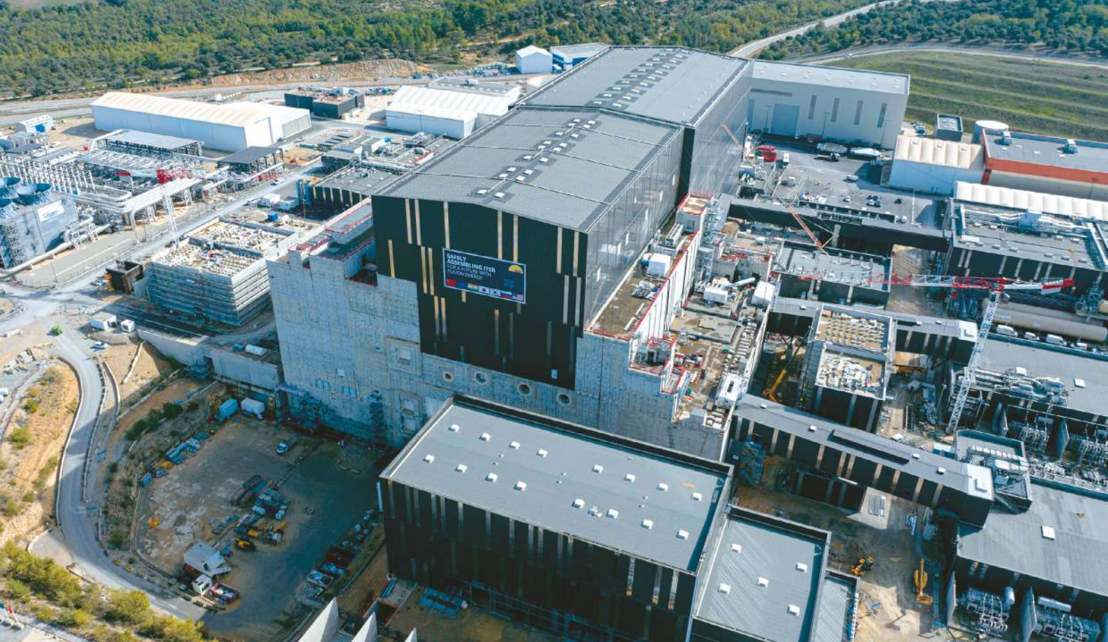
▲ Vue aérienne sur le complexe tokamak avec au premier plan le Bâtiment 37, qui abrite les alimentations électriques à haute tension (1MV) pour les injecteurs de particules neutralisées appelés "HNB" (Heating Neutral Beam), et qui contribuent au chauffage du plasma.
