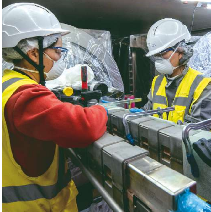
▲ 21 lignes d'alimentation (« magnet feeders ») assureront l'alimentation cryogénique et électrique des aimants supraconducteurs au niveau B2 (sous-sol) du complexe tokamak, chacune formée de trois segments. Sur la photo, des techniciennes qualifiées joignent des segments en réalisant des jointures hautement techniques.
