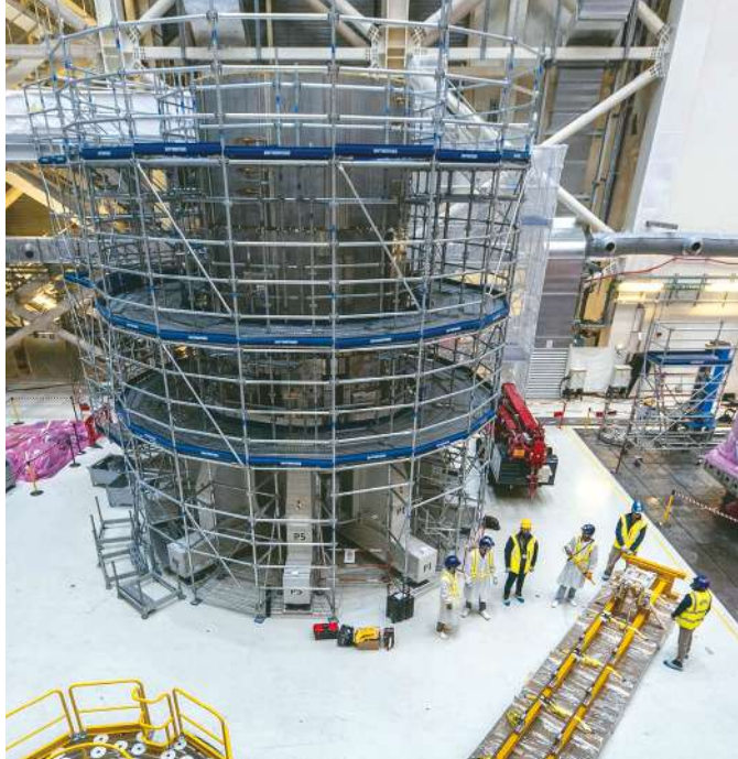
▲ La troisième bobine indépendante du solénoïde central d'ITER a quitté sa plateforme temporaire pour rejoindre la « tour ».
