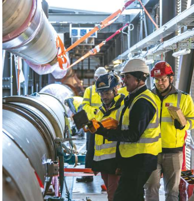
▲ Étant donné son rôle particulier, le positionnement de ce segment de ligne cryogénique est une opération délicate. Celui-ci doit en effet supporter les déplacements dus à un éventuel séisme pour protéger le reste du réseau de lignes cryogéniques.
