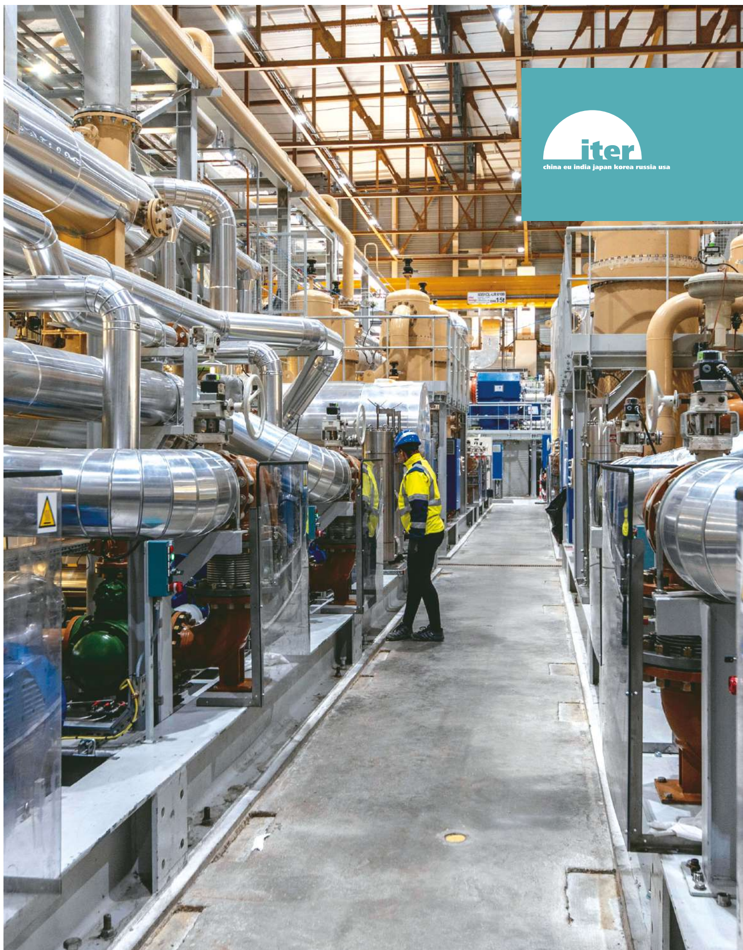
▲ Douze puissants compresseurs, sur un total de 18, sont actuellement en service dans l'usine cryogénique d'ITER. L'hélium liquide à 4 K (moins 269°C) est destiné au système magnétique et aux cryopompes du tokamak, mais aussi à la future installation de test cryogénique.
