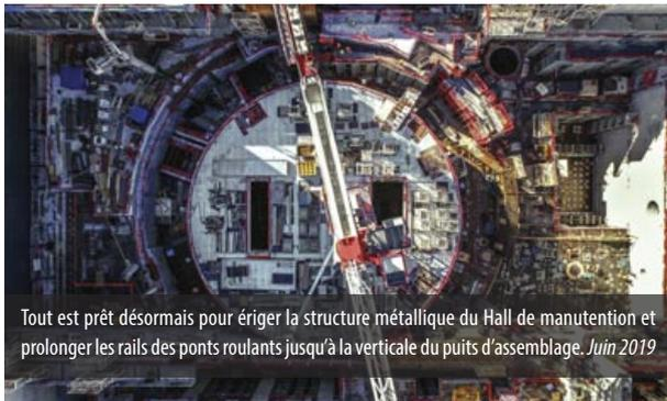
Tout est prêt désormais pour ériger la structure métallique du Hall de maintenance et prolonger les rails des ponts roulants jusqu'à la verticale du puits d'assemblage. Juin 2019
