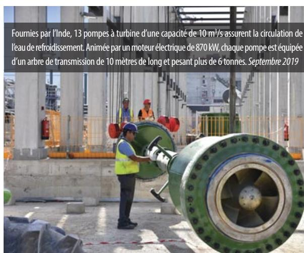
Fournies par l'Inde, 13 pompes à turbine d'une capacité de 10 m<sup>3</sup>/s assurent la circulation de l'eau de refroidissement. Animée par un moteur électrique de 870 kW, chaque pompe est équipée d'un arbre de transmission de 10 mètres de long et pesant plus de 6 tonnes. *Septembre 2019*
