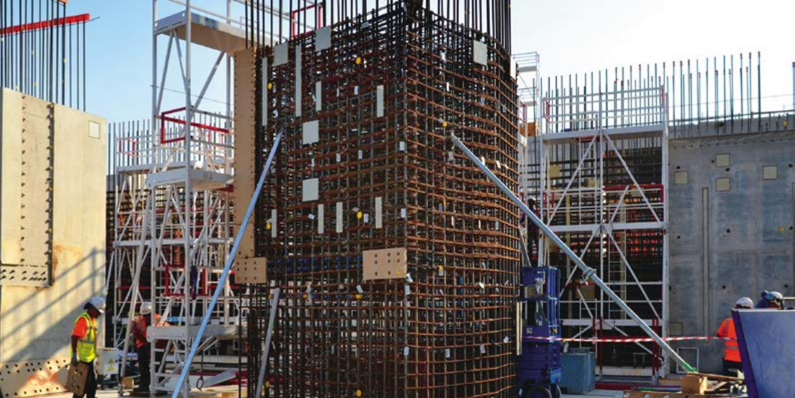
Ces piliers massifs en cours de construction soutiendront le niveau B1 du Bâtiment diagnostics, juillet 2015.
