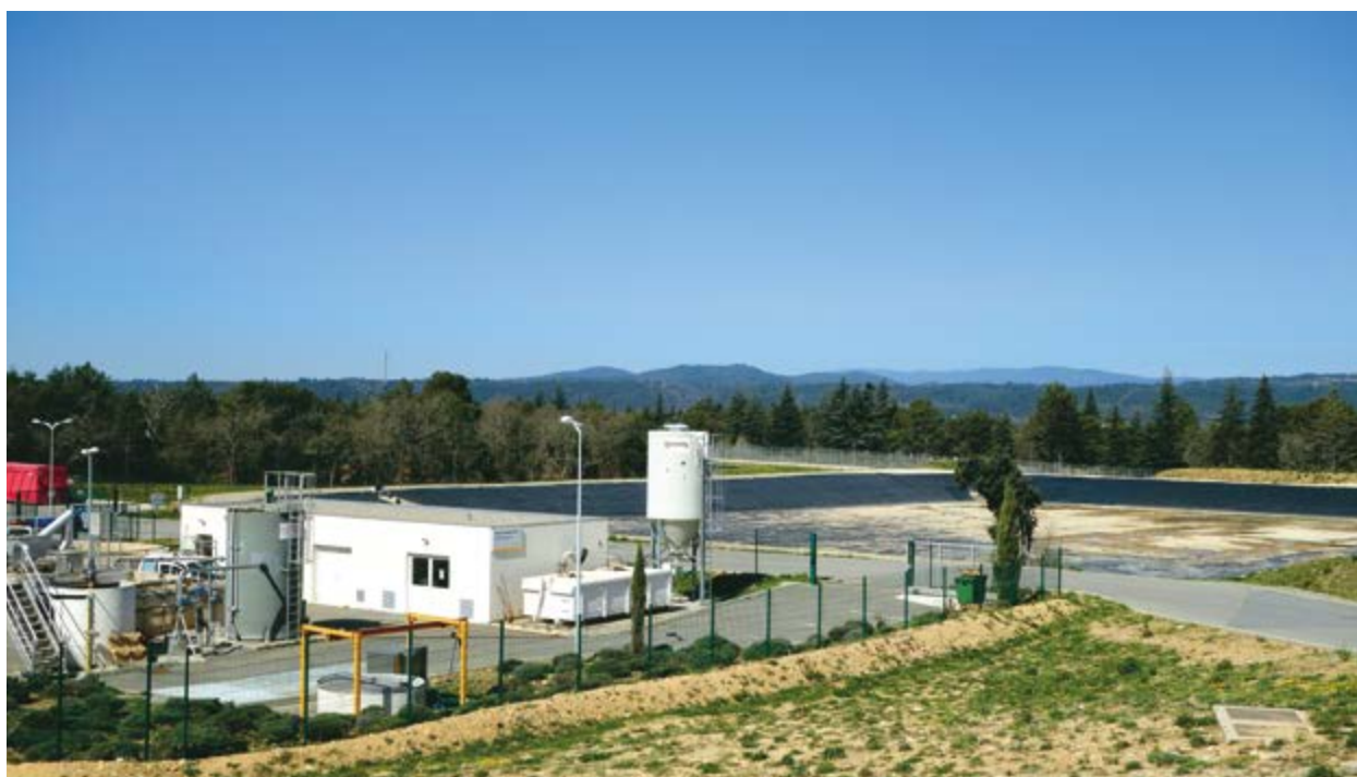
Vue de la station d'épuration et du bassin d'orage sur le site d'ITER.
