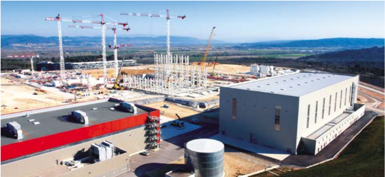
Vue du site de construction avec au premier plan à droite le Bâtiment d'assemblage du cryostat, et à gauche le Bâtiment d'assemblage des bobines poloïdales. Contre le mur de ce bâtiment, se trouvent ses tours de refroidissement, avril 2015.
