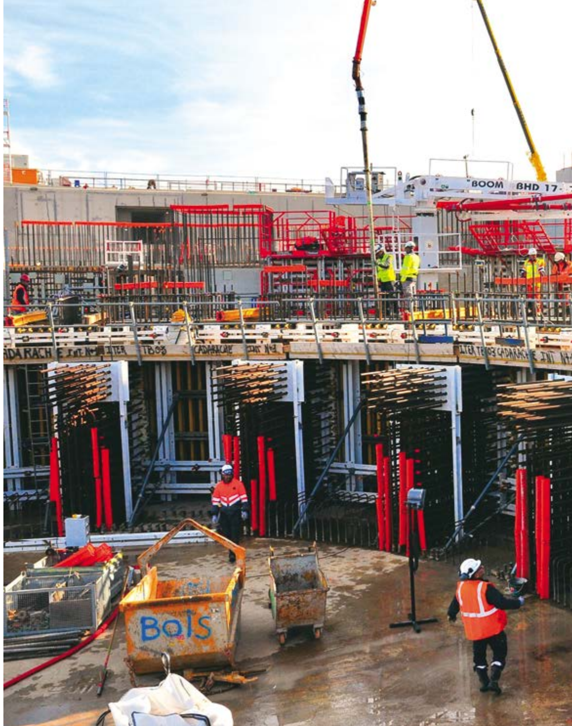
Coulage du béton sur le premier segment de 200° du mur de protection radiologique, octobre 2015.
