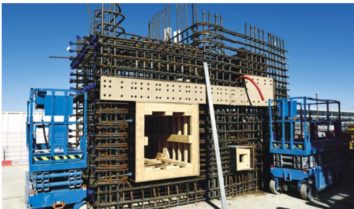
Maquette grandeur nature d'un segment du mur de protection radiologique, février 2015. © F4E
