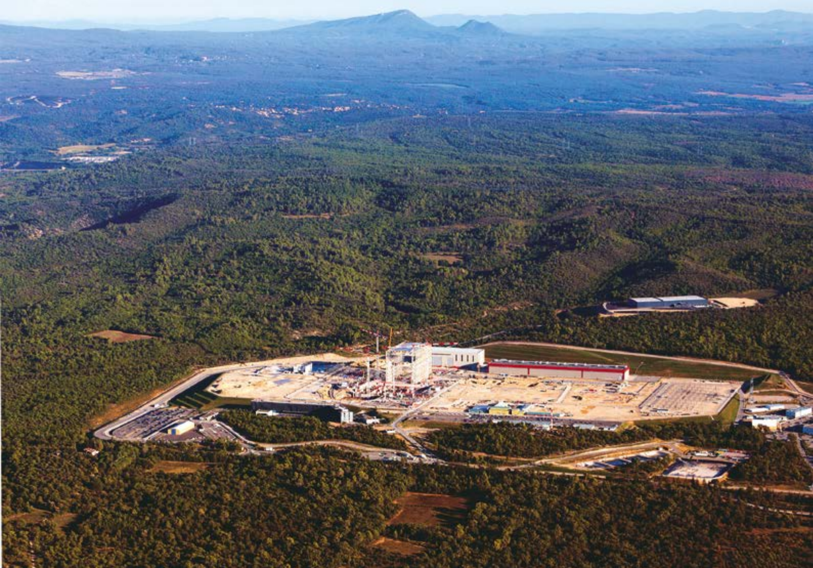
Vue aérienne du site d'ITER et de ses environs. Près de la moitié de la parcelle a été aménagée pour permettre la construction des 39 bâtiments du programme de recherche. A l'arrière-plan, la nouvelle plateforme logistique de 9000 mètres carrés pour l'entreposage des composants, achevée en Juillet 2015. © MatthieuColin.com
